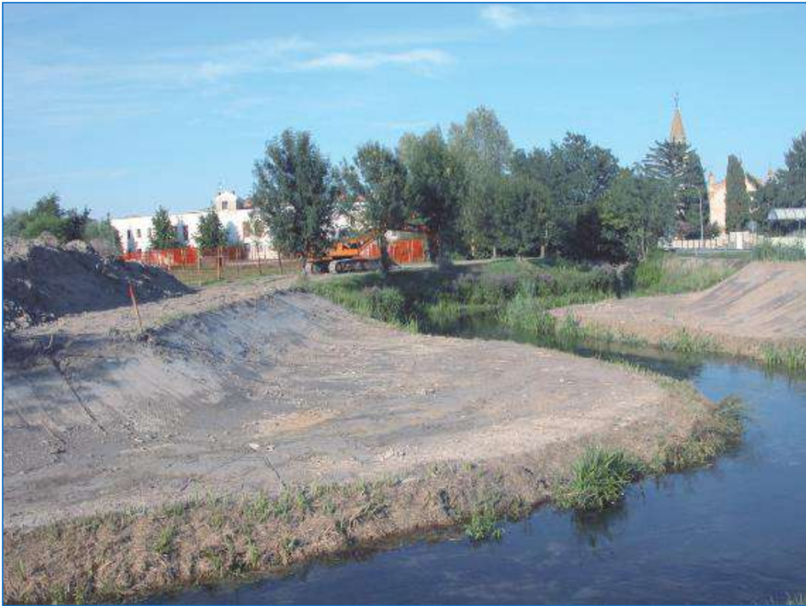
Realizzazione di golene allagabili lungo la Roggia Versiola.
