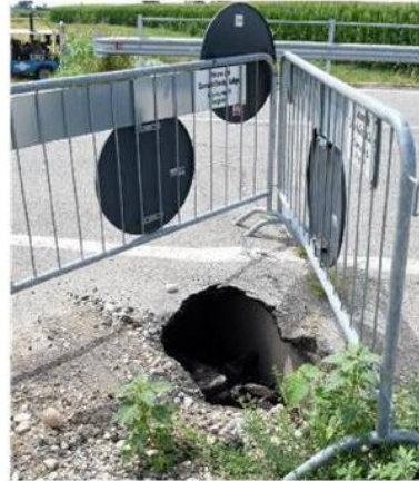
La voragine che si è creata con le piogge in via delle Risaie. DICIANNE FOTO
