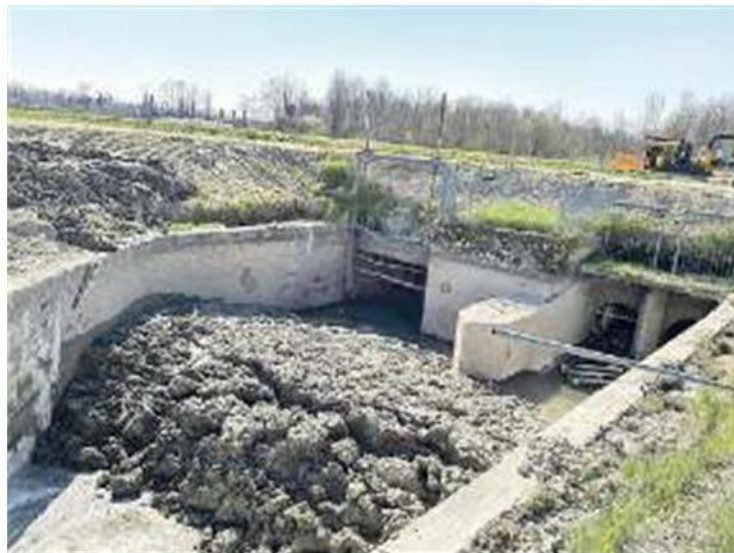
SABOTAGGIO Il cantiere di Acque Risorgive lungo la canaletta che alimenta l'impianto Veritas di Ca' Solaro
