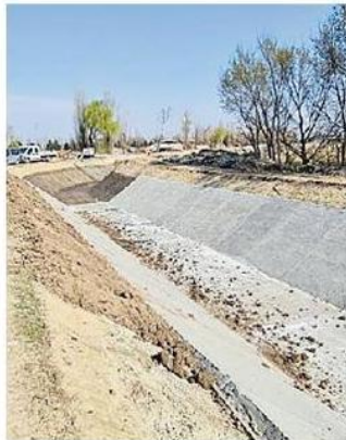
L'area dei lavori
