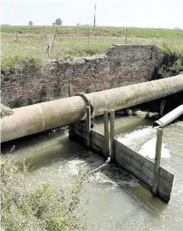
PORTO TOLLE II manufatto Paltanara sul canale Cassella
