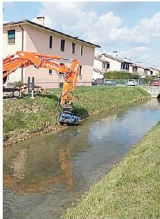
Lavori sullo scolo Orsato
