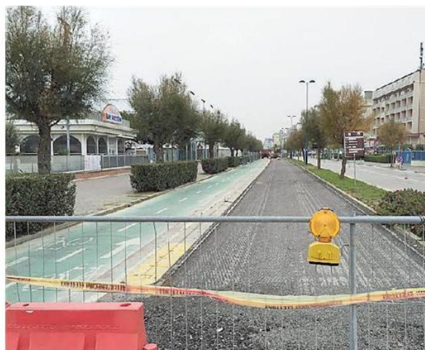
Un cantiere per la costruzione del megatubo aperto ai ai nel 2015
