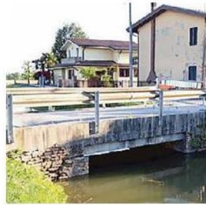
Il ponte di via Boligo
