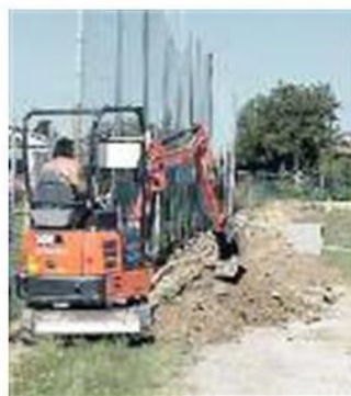
AL LAVORO Gli operai nel cantiere di Noventa
