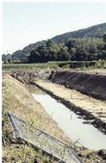
RETE IDRICA Al via i lavori di sistemazione di canali e scoli
