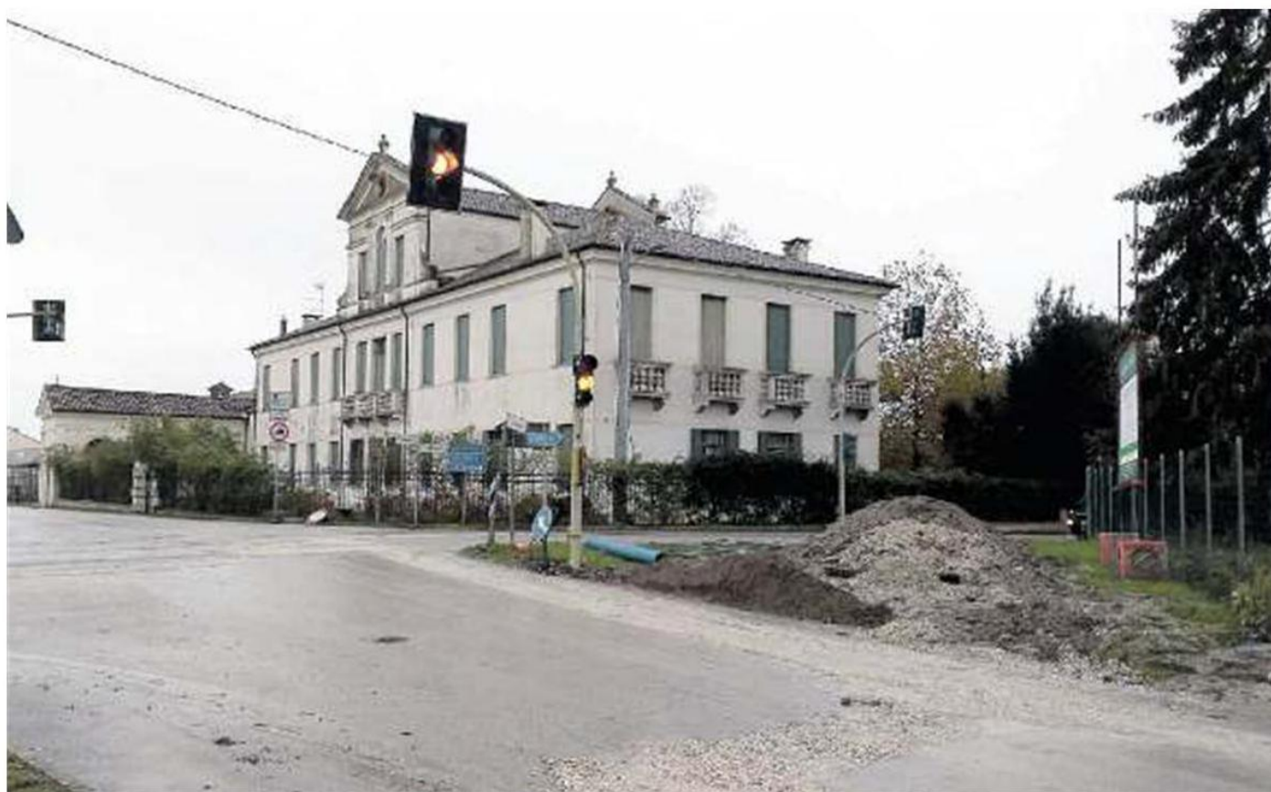
INCROCIO Al posto del semaforo saranno realizzate due rotatorie; in questi giorni sono in corso lavori di Acquevenete
