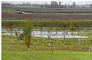
Uno dei due bacini di laminazione realizzati a Bovolone. FOTO: ENNEFOTO
