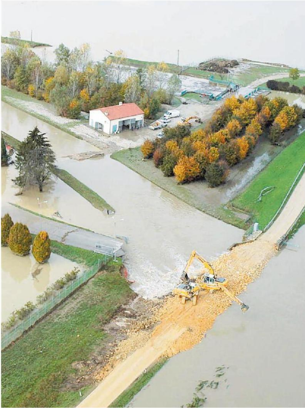
La rotta a Roncasette di Ponte San Nicolò del 2010 che causò l'alluvione
