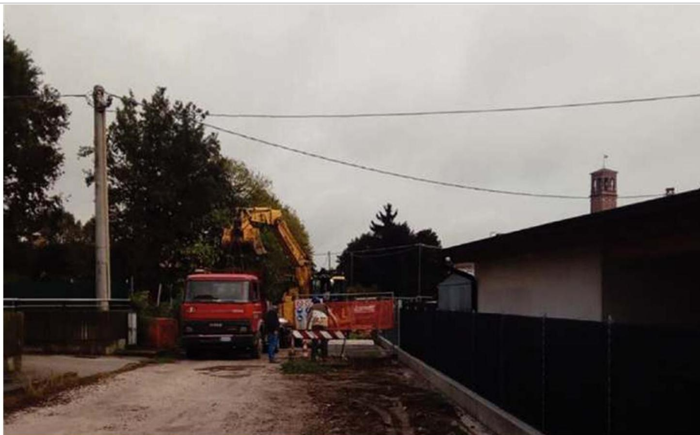
IL CASO Via Silvio Pellico: esposto in procura su presunti abusi riguardo alle recinzioni. Ma il Comune sta sistemando la strada
