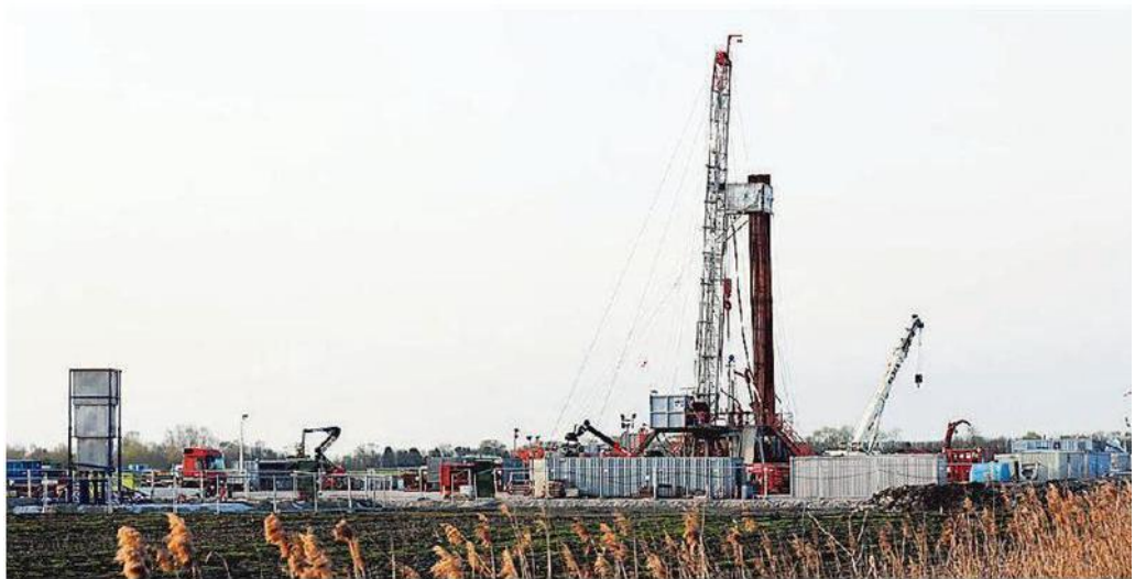
Una delle piattaforme di trivellazione, gestita da Aleanna, per la ricerca del gas nel Mezzano. (FOTO DI IDINI)
