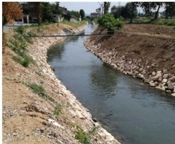
I lavori di sistemazione delle sponde in uno dei corsi d'acqua oggetto del piano di lavori. CAROLLO
