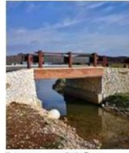
Il nuovo ponte di via Boeca. A1
