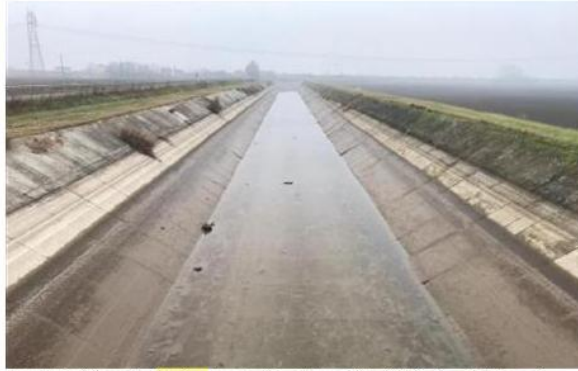
Il canale Leb: il Consorzio di bonifica sta modernizzando i suoi sistemi di irrigazione in 70 Comuni
