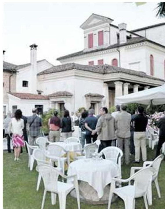
CEDIMENTI Secondo Bano villa Sagredo avrebbe subito alcuni danni
