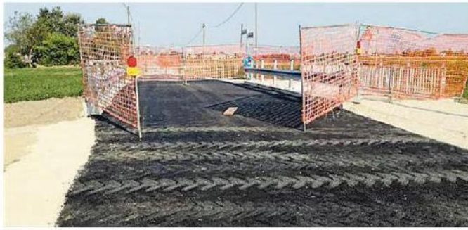
Il cantiere dei lavori di rifacimento del ponte sul Ceresone che riapre
