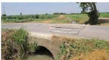
Il ponte sul Dugale è danneggiato e dovrà essere ricostruito DIENE
