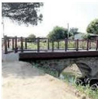
PONTE Terminati i lavori del Consorzio di bonifica
