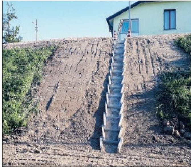
I lavori terminati in via Argine Po
