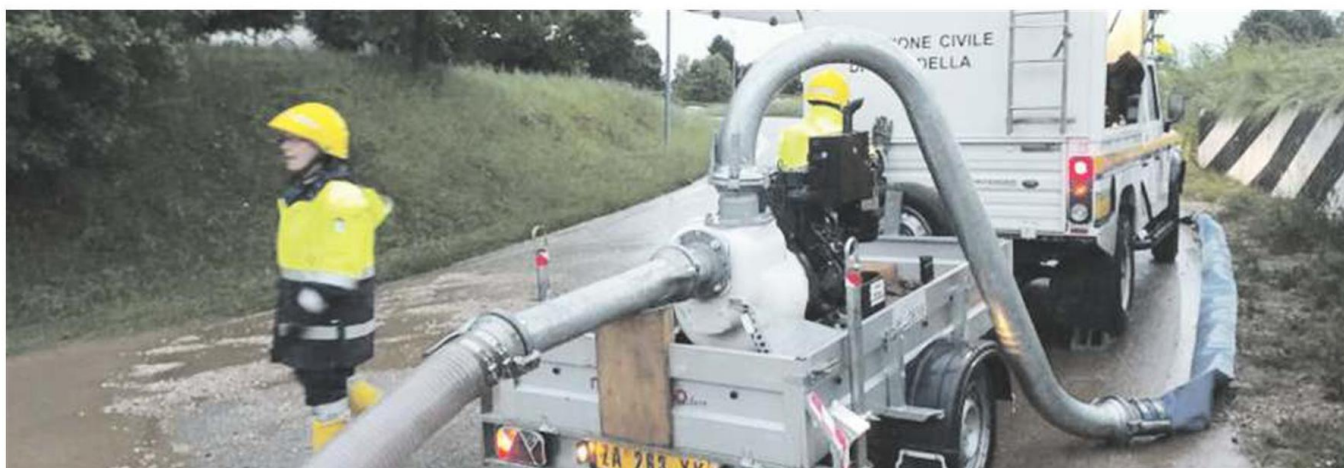
MALTEMPO La protezione civile a Cittadella dove si è riversata una vera e propria bomba d'acqua. Numerosi sono stati gli interventi dopo la pioggia che non sembra lasciare tregua
