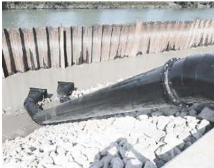
IL CANTIERE Sono ripresi i lavori di completamento dell'impianto idrovoro Altipiano nel Comune di Codevigo
