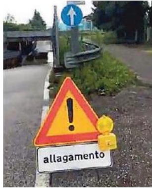
Tunnel allagato a Cadoneghe
