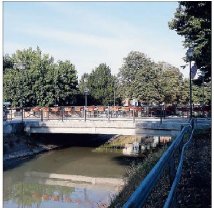
Lavori quasi conclusi al nuovo ponte
