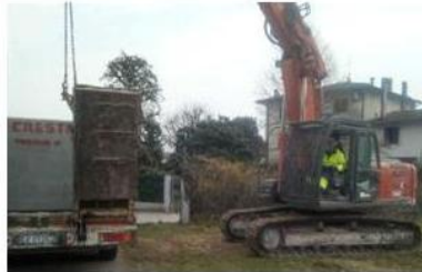
Ruspe al lavoro per la sicurezza idraulica in via Costigiola. NICOLI
