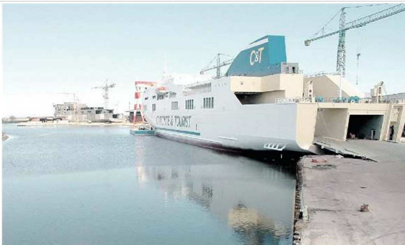
PORTO VIRO Uno scorcio del Cantieri navali Visentini: i traghetti prendono il mare lungo il Po di Levante, che dev'essere dragato
