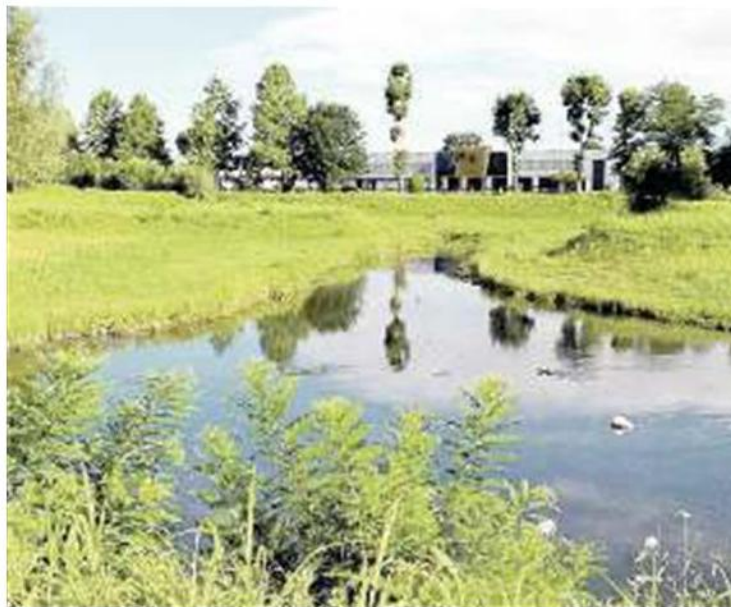
MANUTENZIONE La cassa di espansione realizzata ai Paludei di Fratta
