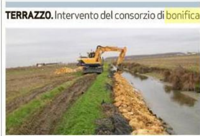
Operai al lavoro sugli argini dello scolo San Marco
