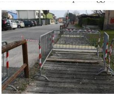
La passerella in legno ormai pericolante in via Mandella. FOTO PECORA
