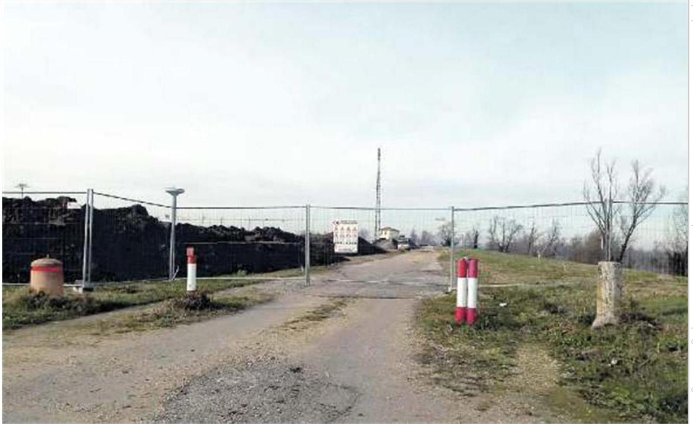
ADIGETTO II Consorzio ha annunciato la fine dell'intervento che ha causato la secca del fiume in corrispondenza di presa Bova
