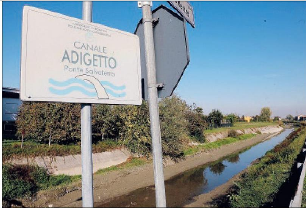
In secca Il corso dell'Adigetto durante i lavori alla presa Bova
