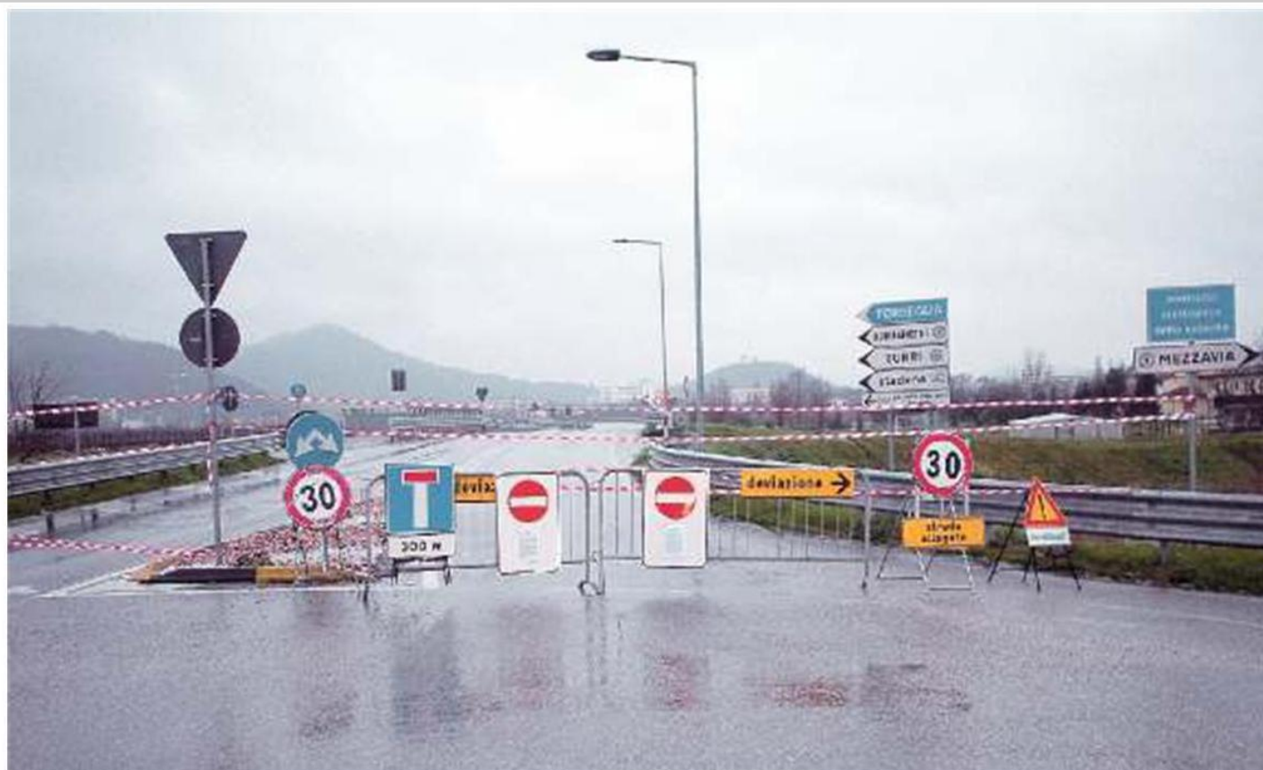
PIANO ANTI-ALLUVIONE Allagamento del sottopasso di Mezzavia. In alto l'assessore alla Pianificazione urbanistica Luca Fanton
