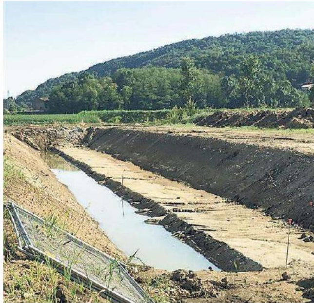
Uno dei lavori di pulizia di fossi e canalette lungo 5 km a Montegrotto
