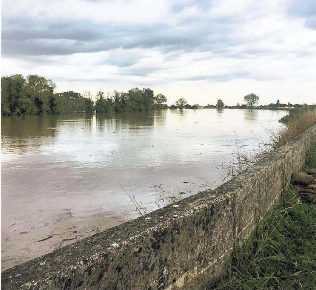
Argine fluviale rafforzato da un muretto: nel Veneto l'opera di consolidamento ha richiesto 411 milioni
