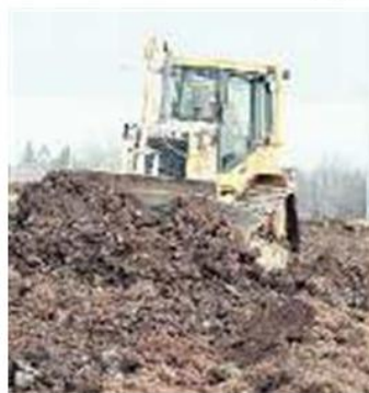
DOPO LA FRANA Completato il lavoro delle ruspe sullo scolo
