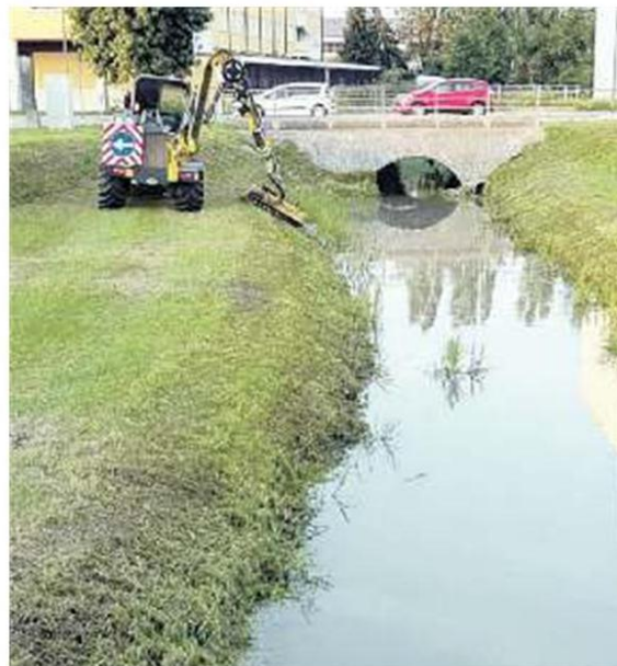
LAVORI Un esempio dello sfalcio in corso in un canale
