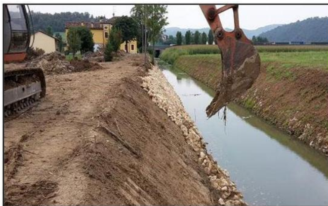
I lavori allo scolo Cordano
