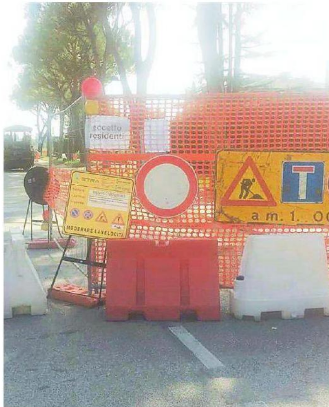
Il cantiere di Etra che blocca l'accesso al quartiere San Domenico
