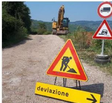
Intervento su via Romano Dian, a Montecchia
