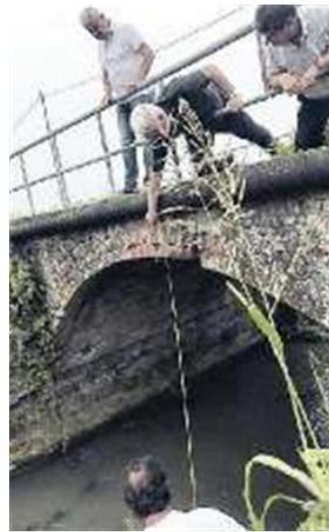
PERICOLOSO Il ponte stradale interrotto sul Ceresone Piccolo
