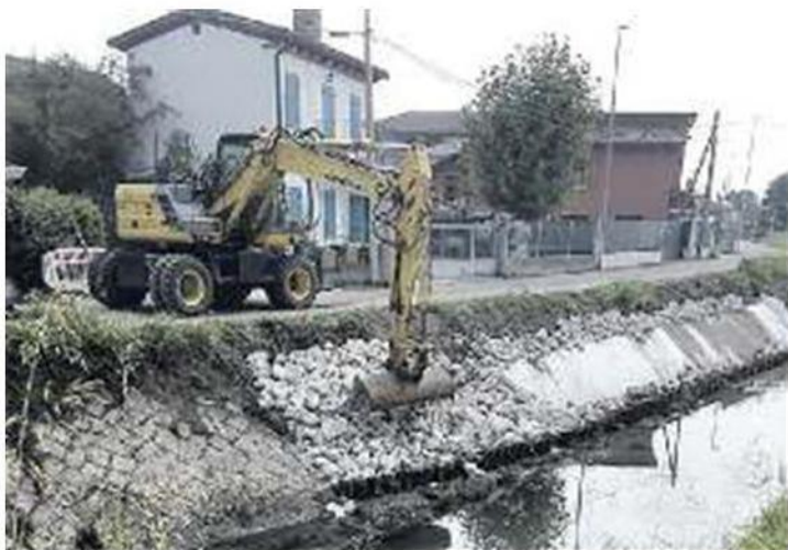
LAVORI Proseguono le opere di consolidamento dell'argine sinistro dello scolo Lazzaretto in via Caselle
