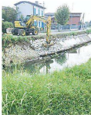
L'intervento in corso a Caselle
