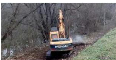
Una ruspa durante i lavori disposti dalla Regione
