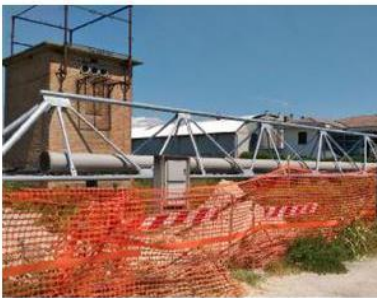
La struttura predisposta da Acque Veronesi in via Alberazzi. DIENNE
