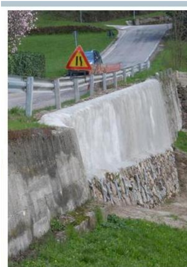
L'intervento di consolidamento lungo via Terrarossa. CARIOLATO
