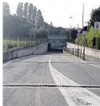
INTERVENTO Il sottopasso era stato aperto nel Duemila
