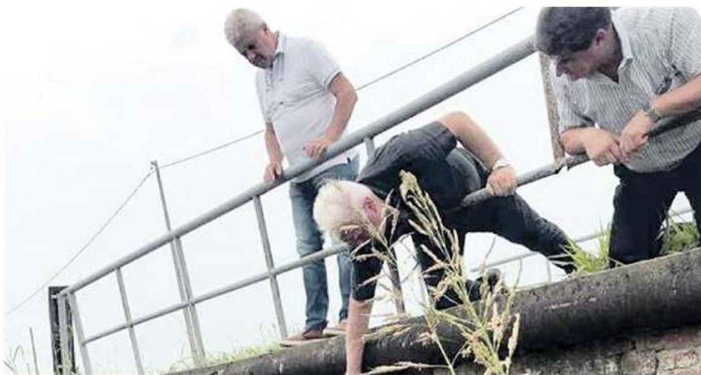
SOPRALLUOGO Il sindaco Agostini assieme ai tecnici del consorzio di bonifica durante le verifiche sul Ceresone piccolo
