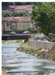
Consolidamento di argini. ARCHIVIO
