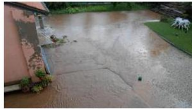
Allagamenti a Costalunga nel 2014
