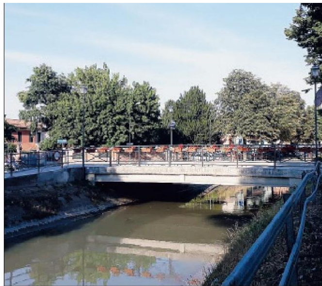
Il ponte in Riviera del Popolo con il marciapiede appena rifatto
