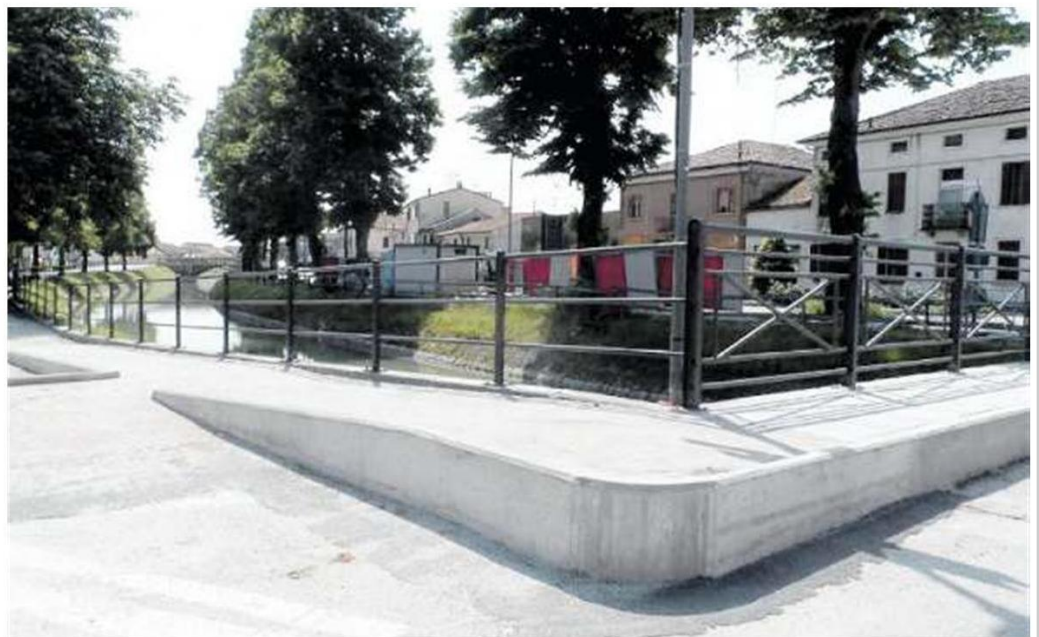
RIQUALIFICAZIONE Il Ponte Nuovo di Lendinara dopo i lavori di sistemazione e abbattimento delle barriere architettoniche
