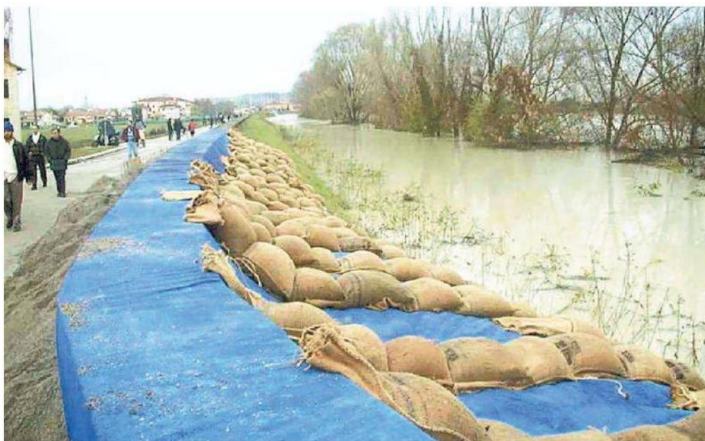
Una soluzione temporanea per rafforzare gli argini del Livenza: ora partono lavori strutturali
