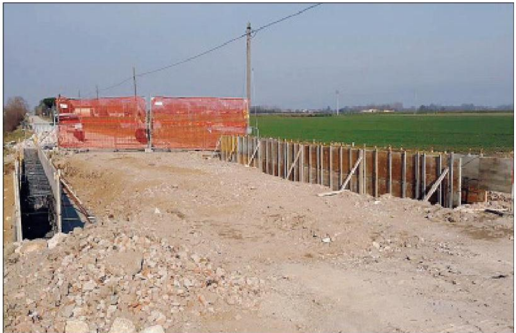
Gli interventi sul ponte a Gavello
