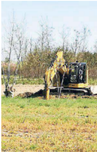
Una ruspa in via Sabbioncello
