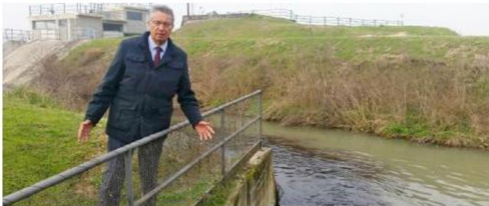
Antonio Pastorello durante il sopralluogo compiuto nel punto in cui il collettore scarica nel Fratta
