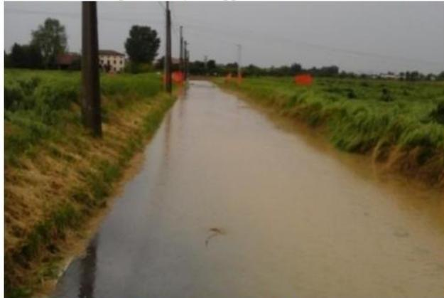
Le cause dell'allagamento sono dovute al sottodimensionamento del vecchio tombinamento
