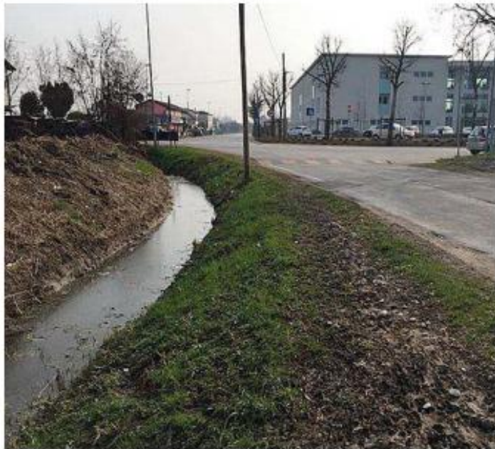
Il nuovo canale di scolo realizzato in via Ongari a Noale (foto Pòrcile)
