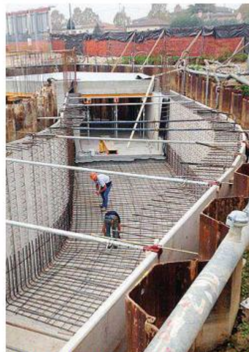
A sinistra la bolletta in arrivo nelle case dei padovani e a destra i lavori del canale scolmatore Limenella-Fossetta
