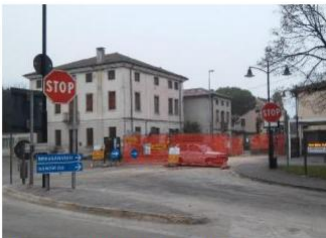
L'incrocio di Poianella chiuso per lavori. FOTO FRISON
