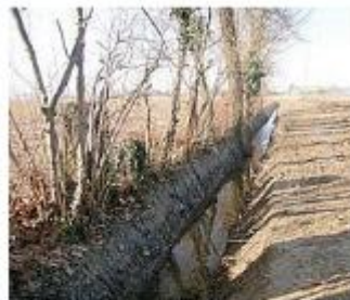
Vicino all'imbocco del canale Angeli
