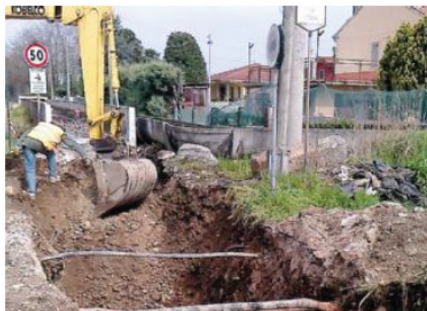
Il cantiere di via San Fermo dove c'era il cippo
