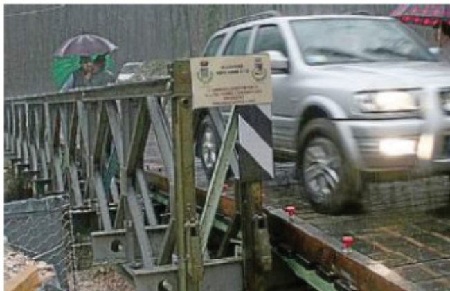
Ponte "Bailey" in contrada Puglia installato d'urgenza nel 2010. S.D.C.
